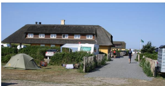
Figur 6 Servicebygning beliggende indenfor planområdet
